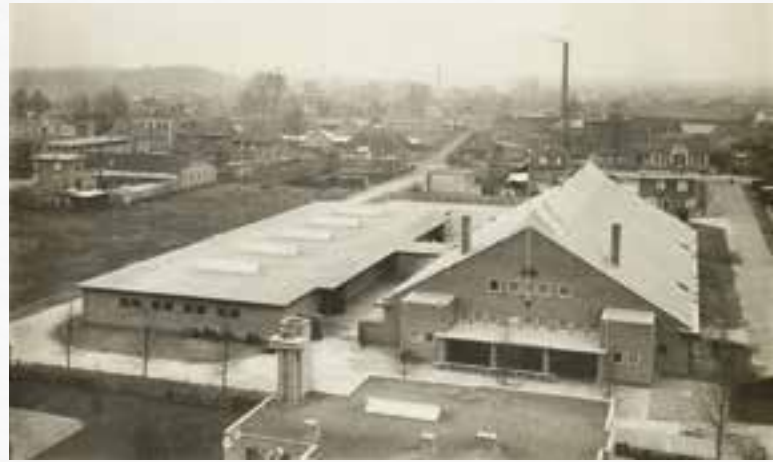
De 'nieuwe' eierhal, gebouwd op het voormalige landgoed Welgelegen, werd geopend op 16 november 1931 door burgemeester Roosmale Nepveu. De hal, met meer dan 1000 m² vloeroppervlak, was veel meer dan een ruimte waar eieren verhandeld werden. Er vonden allerlei tentoonstellingen plaats, van pluimvee, maar ook van bloemen en automobielen en huishoudartikelen. De foto geeft een mooi overzicht van het oude Welgelegen west in de jaren dertig van de vorige eeuw. Iets boven het midden, van links naar rechts de Deventerstraat met links de daaraan gelegen villa Wilhelmina. De schoorsteen rechts is die van de zuivelfabriek Mariëndaal, met links daarvan de Noorderlaan die uitkomt op de Deventerstraat. In het verlengde daarvan de Halstraat. Rechts op de foto de voormalige Slachthuisstraat, nu Weidestraat. Foto CODA archief.
