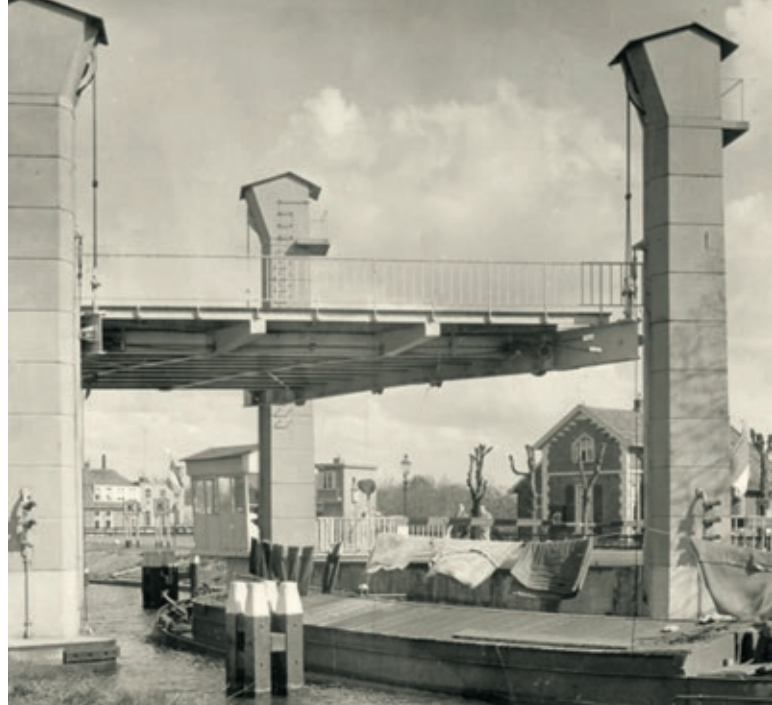
De hefbrug in werking. Foto van vóór de restauratie in 2002. In 1972 voeren de laatste boten langs de Welgelegenbrug. Zichtbaar is ook de brugwachterswoning (1880). Bron: beeldarchief CODA.
