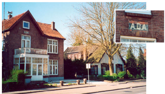
Deventerstraat 94. Eertijds het hoofdkantoor van de autobusdienst. Bron: CODA-archief.
