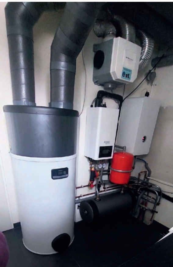
▲ Links op de foto is de warmtepompboiler, deze is voor tapwater (douchen), het middelste apparaat is de hybride warmtepomp voor de verwarming en het rechter apparaat is een elektrische cv-ketel als back-up voor de verwarming als het koud is.
