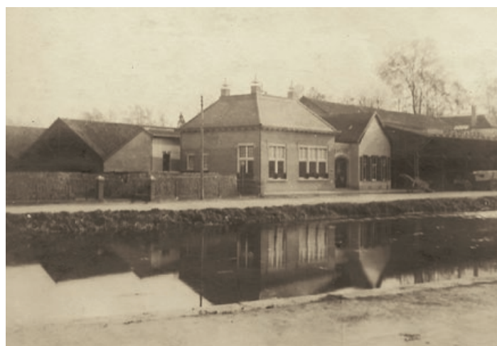
Kanaal Noord 122. Kantoorgebouw uit 1915 van Houthandel Fa. J.H.C. van Rijen. De eerste steen is gelegd door directeur Ype Rodenhuis (1870-1926). Naast het poortje rechts het woonhuis. Collectie Berry Meester.
